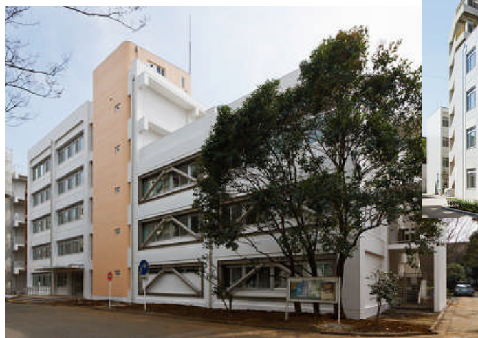
(西3号館 H25.3月竣工)
