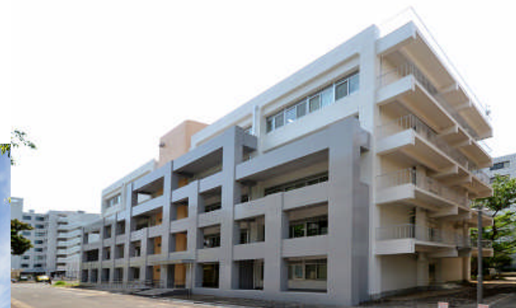
(西1号館 H25.3月竣工)
