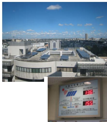
東4号館屋上に設置した太陽光発電パネル
