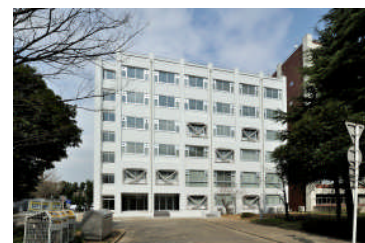
西 4 号館改修（耐震補強）
