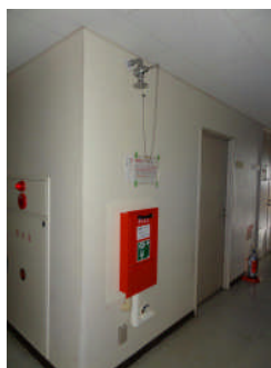
洗眼器(アイシャワー)の設置状況 上部は緊急用シャワー 洗眼器(アイシャワー)を開くとすぐに洗眼することができます
