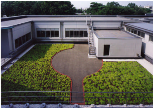
東3号館の屋上緑化
