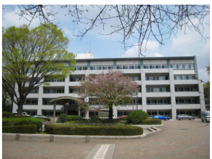
全面改修した本館
