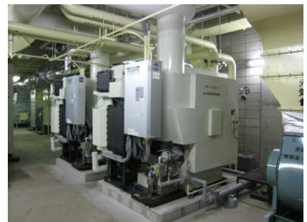
講堂空調設備更新
