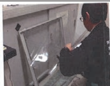
飛散防止フィルム貼付状況
