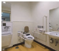
多目的トイレ
