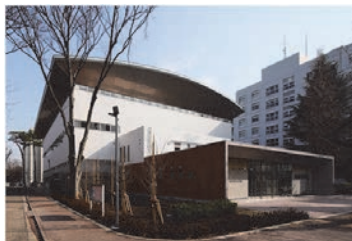
改築した体育館
