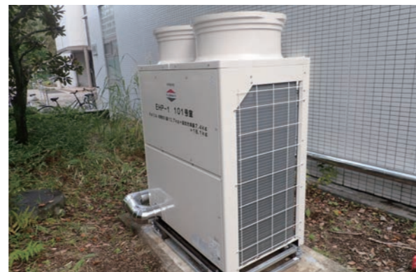
【写真1】更新された新しい空調室外機（A棟）
