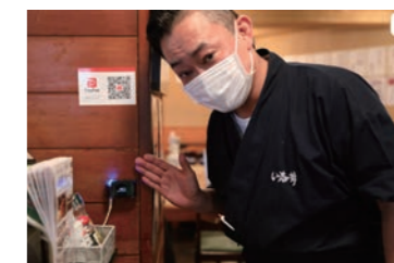
(図3-1) 小型CO2センサーの設置事例 (居酒屋)
