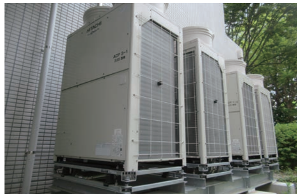
【写真1】更新された新しい空調室外機 (西9号館)
