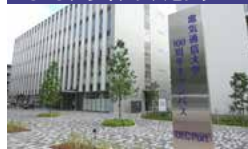
北西(甲州街道 府中方向)からの写真
